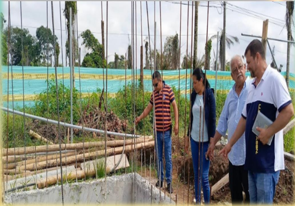
Inspección Obra Estadio
