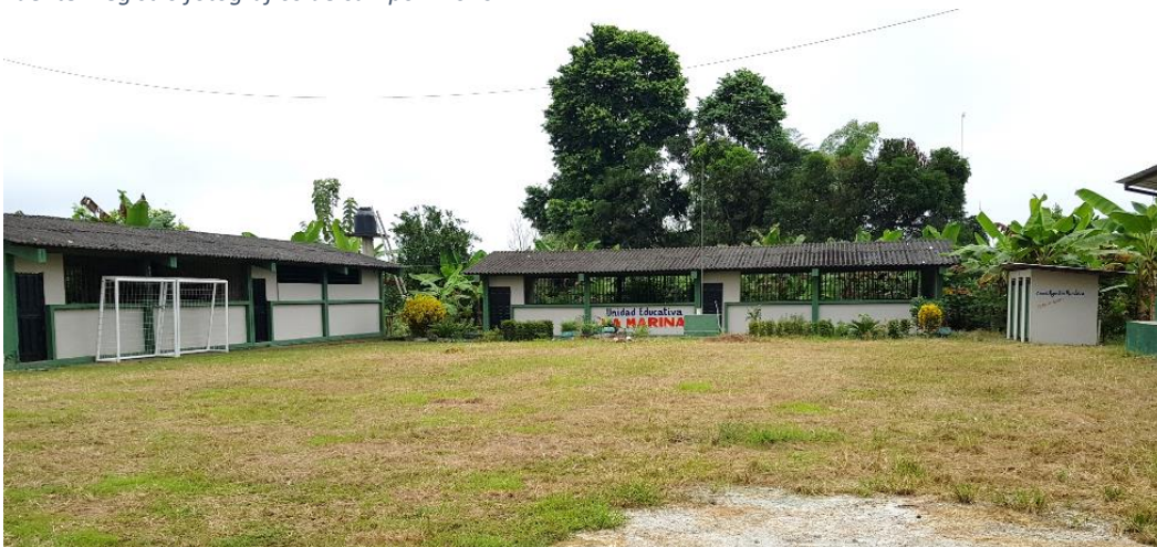
Ilustración 62-Unidad educativa, recinto Sinaí Fuente: Registro fotográfico de campo – 2020
