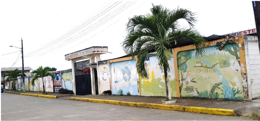
Ilustración 66-Unidad educativa Estenio Burgos, Cabecera Parroquial Fuente: Registro fotográfico de campo – 2020
